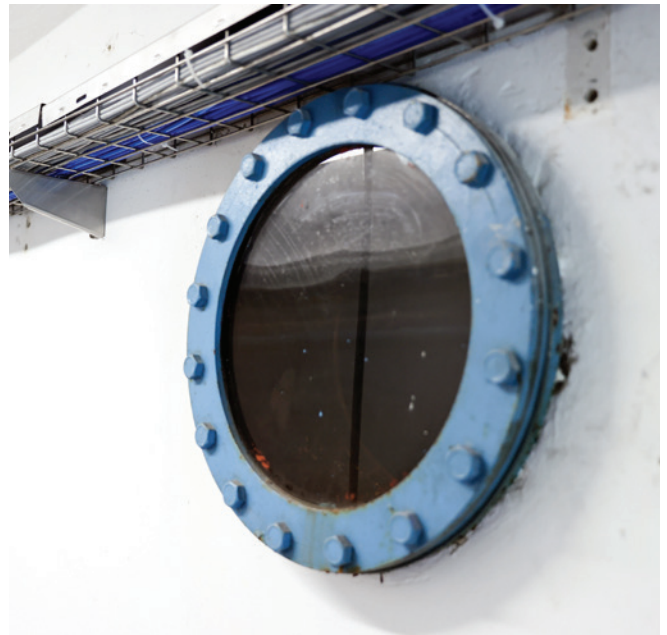
Del tehnološke opreme predstavlja ozonski bazen, v katerem se surovi vodi dodaja ozon.
