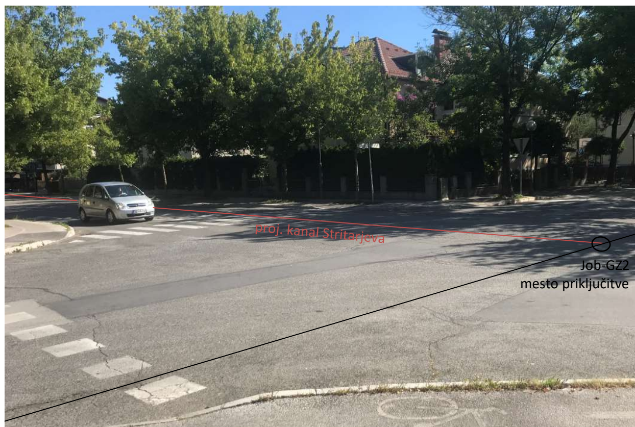
Slika: Priključitev kanalizacije na obstoječi kanal v križišču Kersnikove in Stritarjeve ulice.
