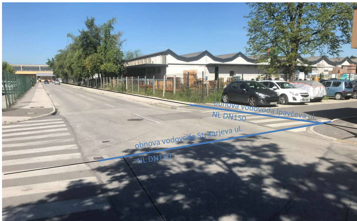
Slika: Obnova vodovoda v križišču Stritarjeve in Ipavčeve ulice.
