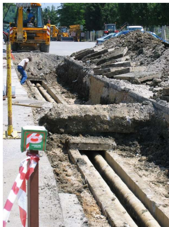
Slika: Obstoječ vročevod DN50 v bližini križanja s predvidenim vodovodom
