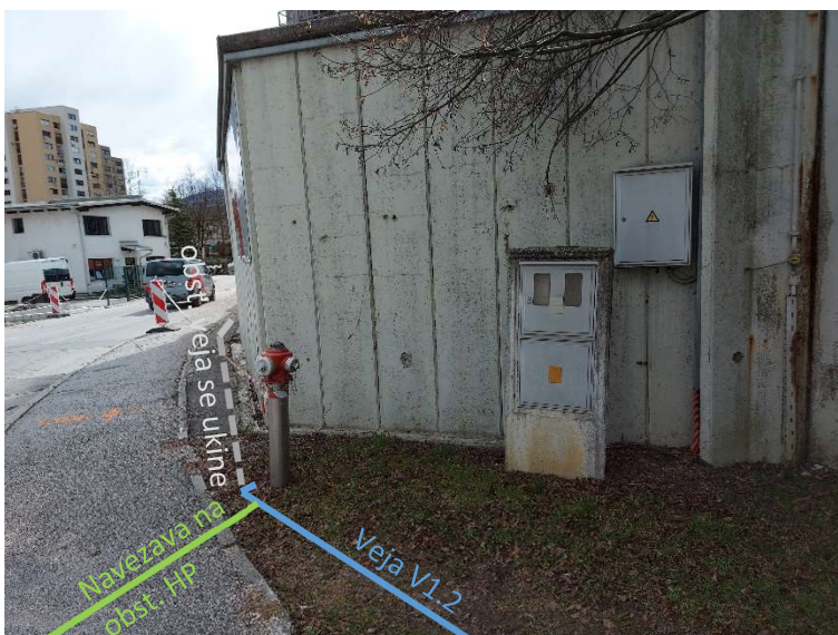
Slika 8: Obstojč nadzemni hidrant se ohrani
