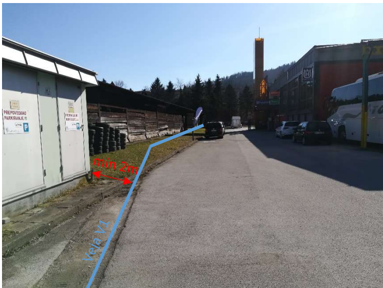
Slika 4: Mimo transformatorske postaje poteka v min razmiku 2m
