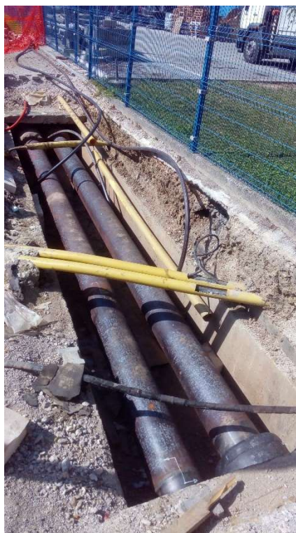
Slika: Obstoječ vročevod DN350 v bližini križanja s predvidenim vodovodom
