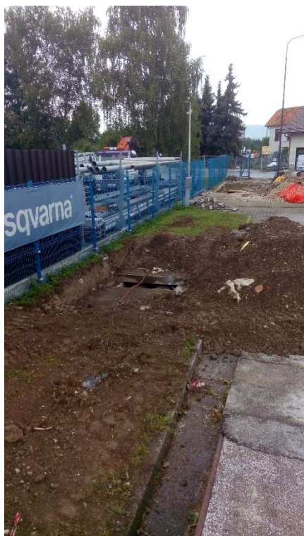
Slika: Obstoječ vročevod DN350 v bližini križanja s predvidenim vodovodom
