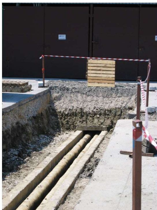
Slika: Obstoječ vročevod DN50 v bližini križanja s predvidenim vodovodom
