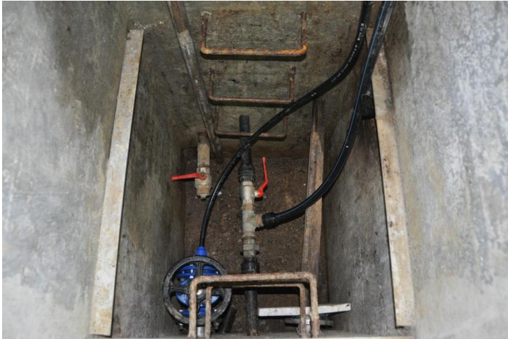
Slika 3: notranjost armaturne celice
