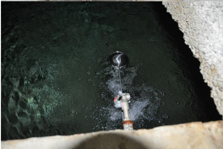
Slika 4: notranjost vodne celice s plovcem
