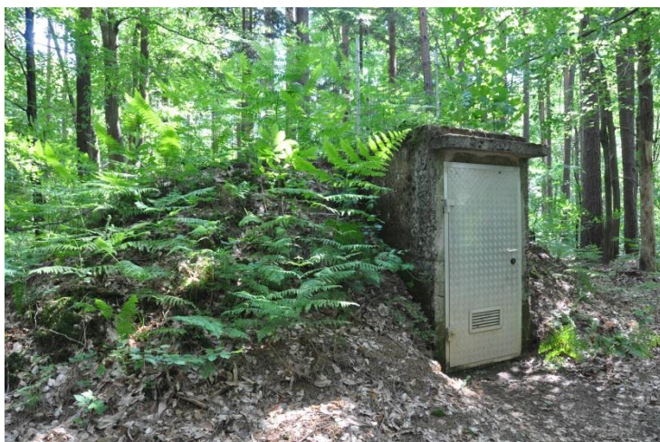
Slika 1: obstoječi vodohran z armaturno celico
