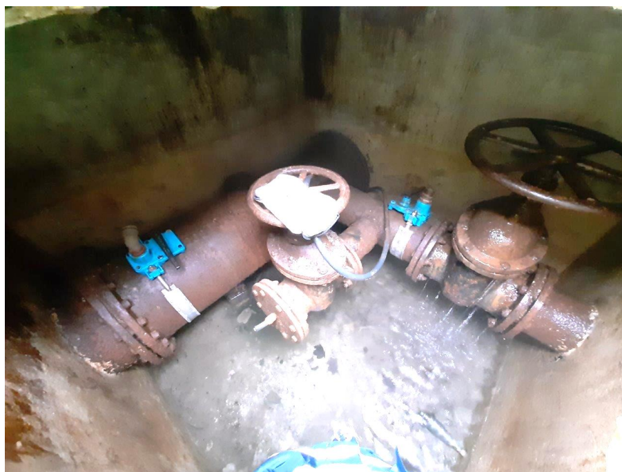
notranjost obstoječega vodovodnega jaška predviden za obnovo in rekonstrukcijo
